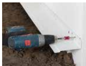
Na založenie nad soklom vždy volíme zakladacie lišty na externé zateplenie
