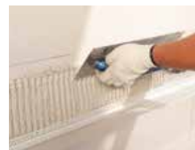
Na založenie nad soklom vždy volíme zakladacie lišty na externé zateplenie
